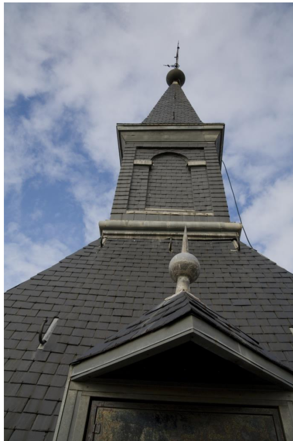
Torreón oeste. Detalle de cubierta.
