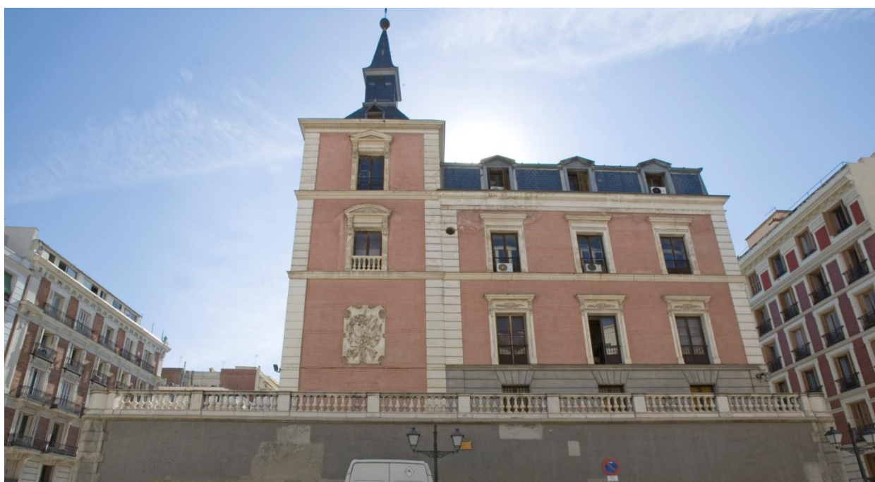
Fachada lateral oeste.
