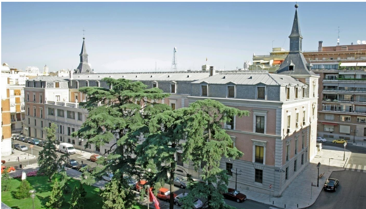
Fachada principal sur.
