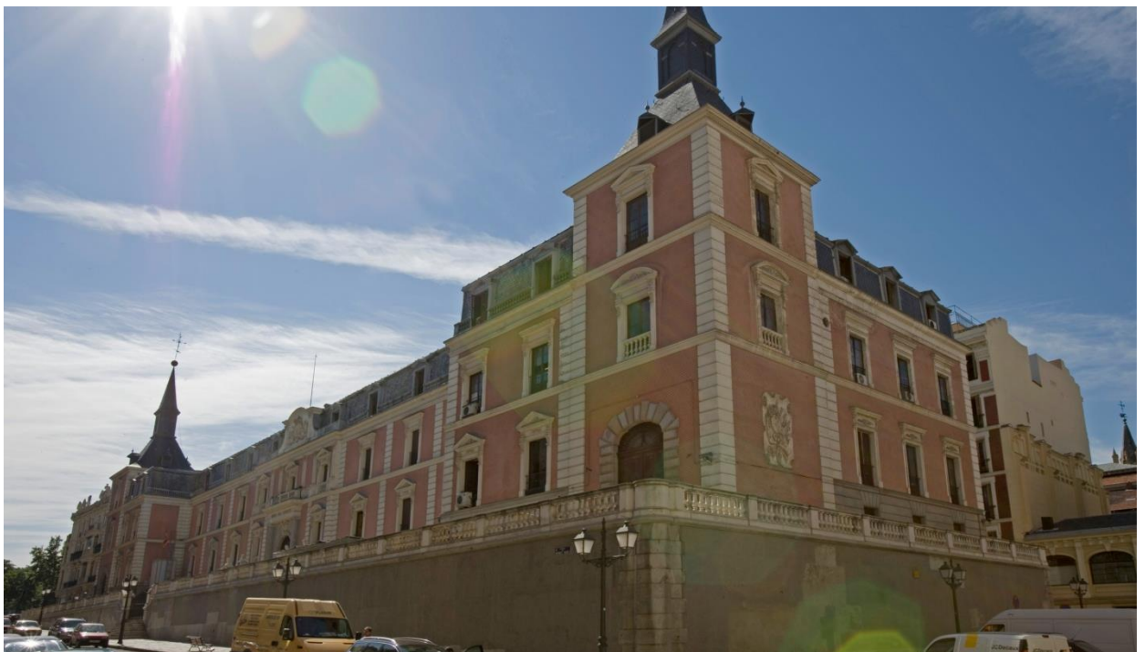
Fachada principal norte y fachada lateral oeste.
